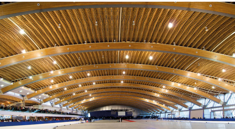
Fot. 3. Przekrycie z drewna klejonego hali sportowej Richmond Olympic Oval wykonane z drewna klejonego; proj. biuro Canon Design (arch. Bob Johnston z zespołem, 2006–2008; rozpiętość 100 m
