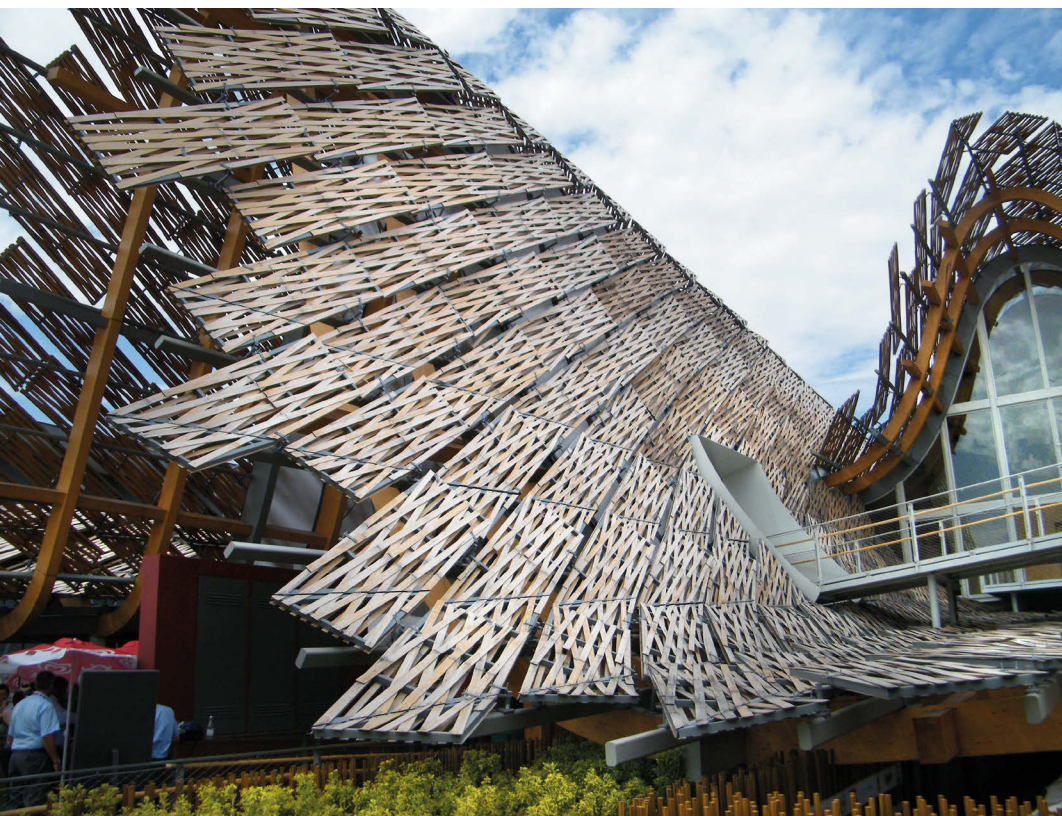
Fot. 1. (na poprzedniej stronie) Pawilon Japonii na wystawie Expo 2015 w Mediolanie Fot. 2. (powyżej) Pawilon Chin na wystawie Expo 2015 w Mediolanie – wspólny projekt Uniwersytetu Tsinghua i Studio Link-Arcfot
