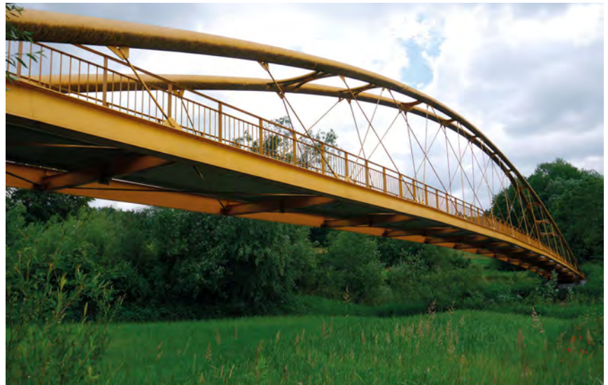
Fot. 3. Kładka dla pieszych w Woli Wieruszkiej
