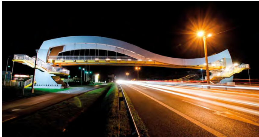
Fot. 2. Kładka dla pieszych nad „Zakopianką” w Myślenicach (fot. Pracownia Projektowa F-11)
