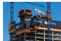
Fot. arch. PERI
