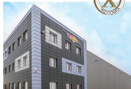
Fot. arch. Blachy Pruszyński
