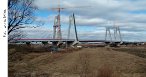
S7 Kraków Nowa Huta – Kraków Przewóz
