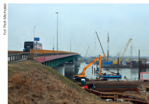
S7 Gdańsk – Elbląg. Budowa mostu na Wiśle w Kieźmarku
