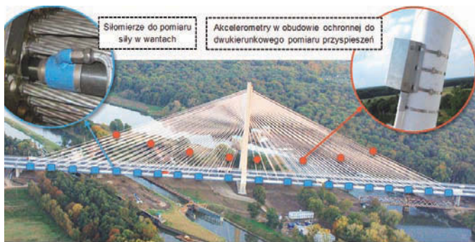
Rys. 11. Elementy składowe systemu monitorowania Mostu Rędzńskiego służące ocenie stanu technicznego wian podwieszających [na podstawie 11]
