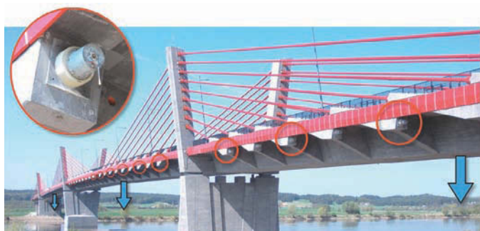
Rys. 13. Schemat rozmieszczenia wybranych czujników systemu monitorowania mostu przez rz. Wisłę koło Kwidzyna (siły wciągach oraz przemieszczenia pionowe) [na podstawie 13]
