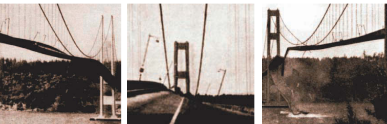
Rys. 2. Katastrofa mostu wiszącego w Tacoma Narrows, blisko Seattle, USA, w wyniku flateru giętno-skrętnego przęsła mostu przy silnym wietrze (1940 r.) [4]
