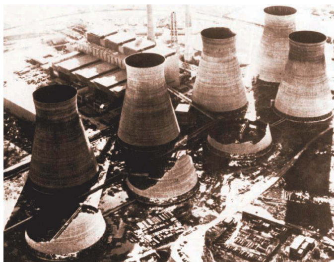
Rys. 1. Katastrofa trzech z ośmiu ponad 100-metrowych żelbetowych chłodni kominowych w Ferrybridge, Wielka Brytania. Zniszczeniu uległy chłodnie zawietrzne. Przyczyną katastrofy były zjawiska interferencji aerodynamicznej chłodni zawietrznych z nawietrznymi o charakterze nieustalonym, które wywołały nadmierne drgania chłodni zawietrznych [4]
