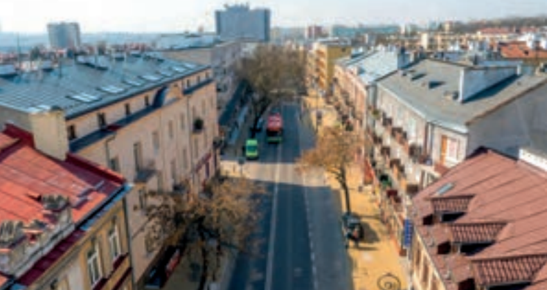
Przebudowa ul. Narutowicza wraz z ulicami przyległymi (etap I) oraz adaptacja budynku przy ul. Narutowicza 32a na potrzeby Państwowej Szkoły Muzycznej I i II stopnia im. T. Szeligowskiego
