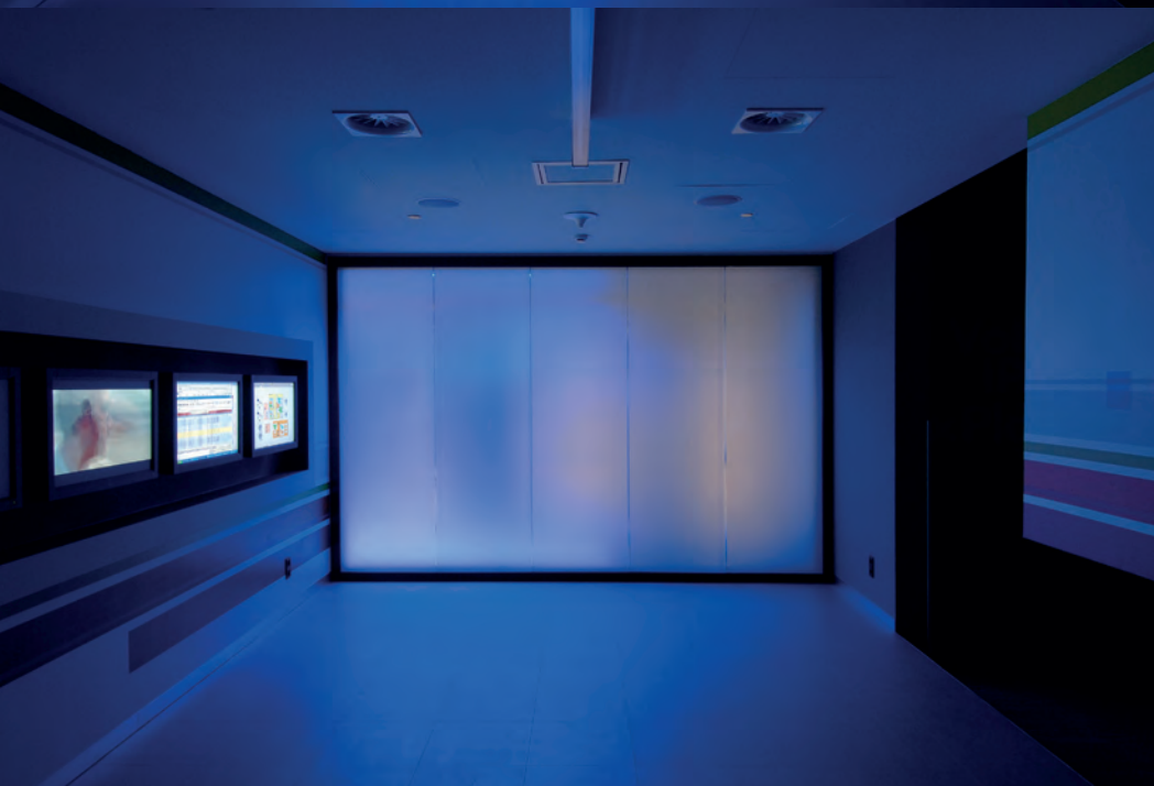
PRIVA-LITE jest szkłem laminowanym, w którym umieszczono folię zawierającą ciekłe kryształy (LC). Pod wpływem pola elektrycznego (100 VAC) ciekłe kryształy ulegają uporządkowaniu, a szkło staje się przeźroczyste. Po odcięciu dopływu prądu szkło wraca do wyglądu matowego (producent: Saint-Gobain)
