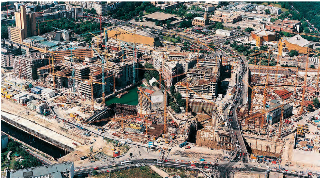
Fot. arch. PERI
