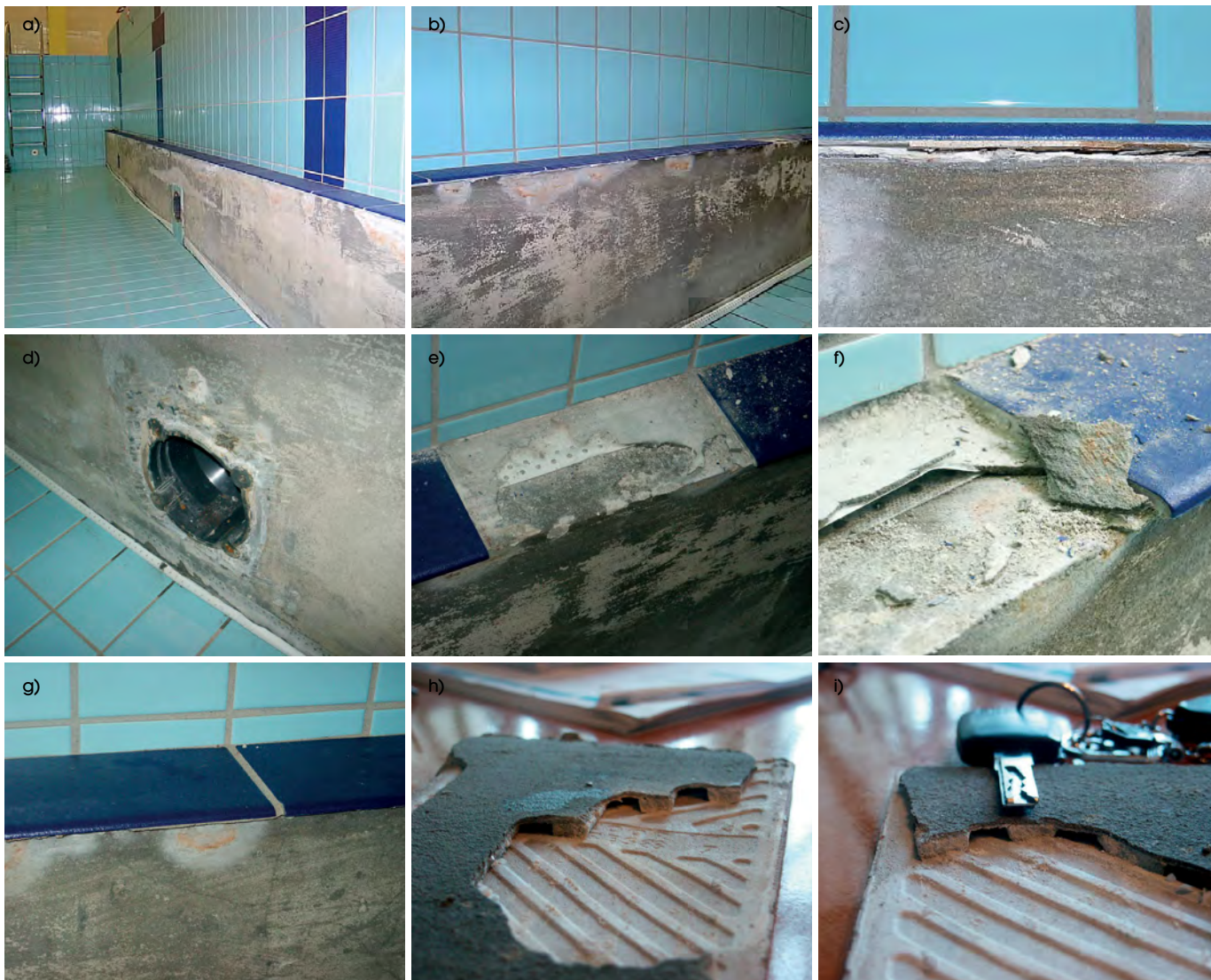
Fot. 3. Uszkodzenia hydroizolacji i okładziny ceramicznej niecki. Opis w tekście
