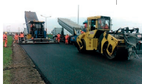
Fot. arch. Strabag
