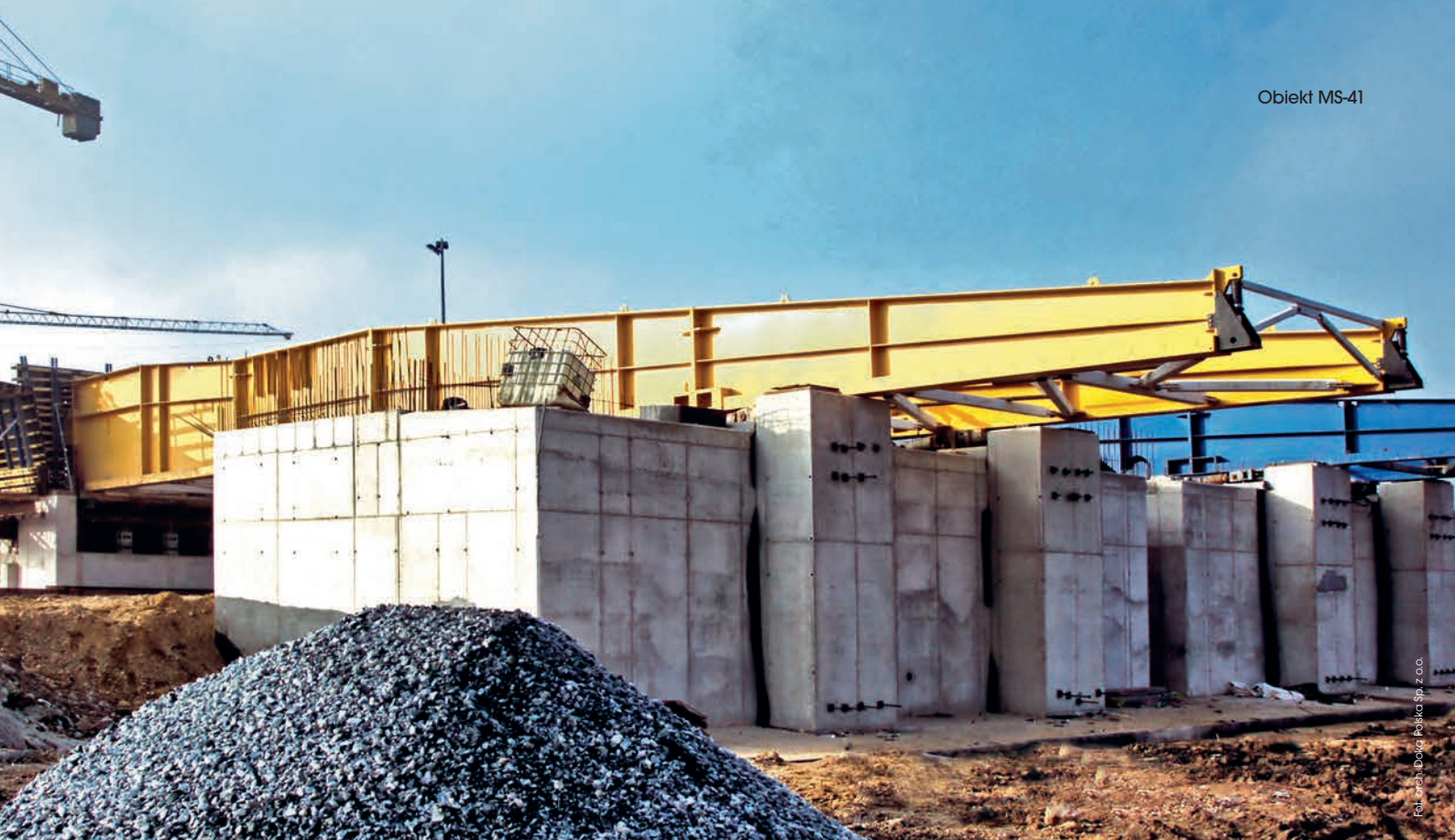
Deskowanie segmentu pośredniego na stanowisku nasuwania
