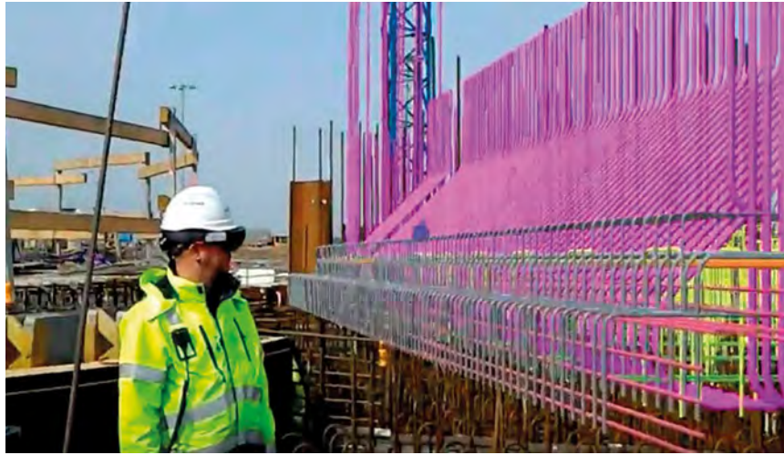
Rys. 1. Wizualizacja zakresu prac planowanego do realizacji na budowie z zastosowaniem rozszerzonej rzeczywistości – projekt European Spallation Source w Szwecji. Materiały Skanska 2017
