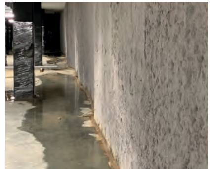
Fot. 8. Ściana szczelinowa po naprawie
