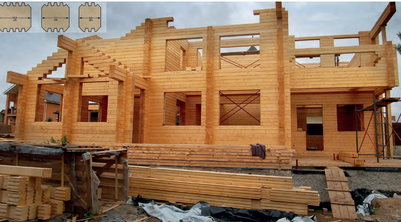
Ryc. 4. Montaż zrębowego domu z belek z drewna klejonego; u góry: przykładowe kształty i wymiary profili belek; Źródło: Wikimedia Commons ( https://commons.wikimedia.org/wiki/File:Возведение_дома_из_клееного_бруса1.jpg , fot. S. Glazkina, 2006)
