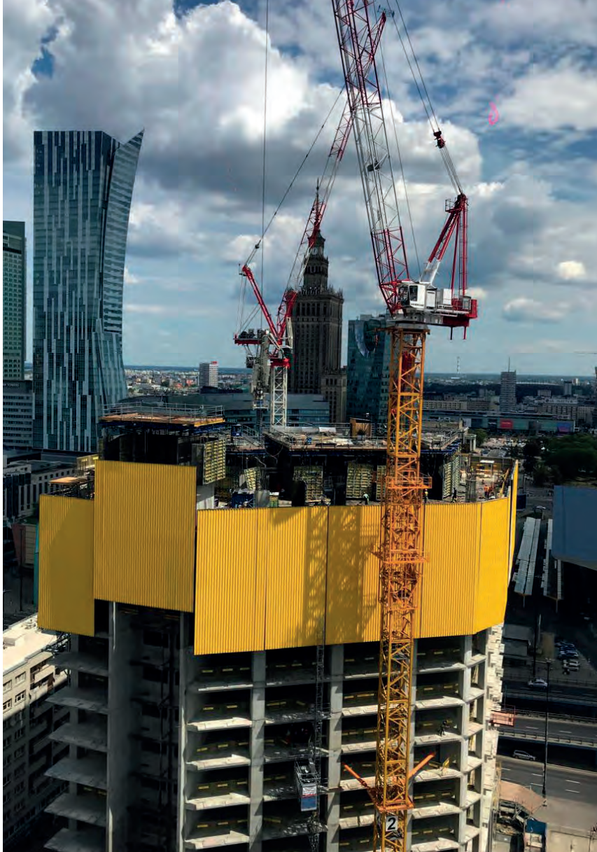
Fot. 6. Specjalne dźwigi, które posłużą po wydłużeniu do montażu iglicy oraz widok deskowania firmy Doka. Wznoszenie tak wysokiego budynku wymaga właściwej koordynacji pracy na budowie oraz zastosowania specjalistycznych deskowań
