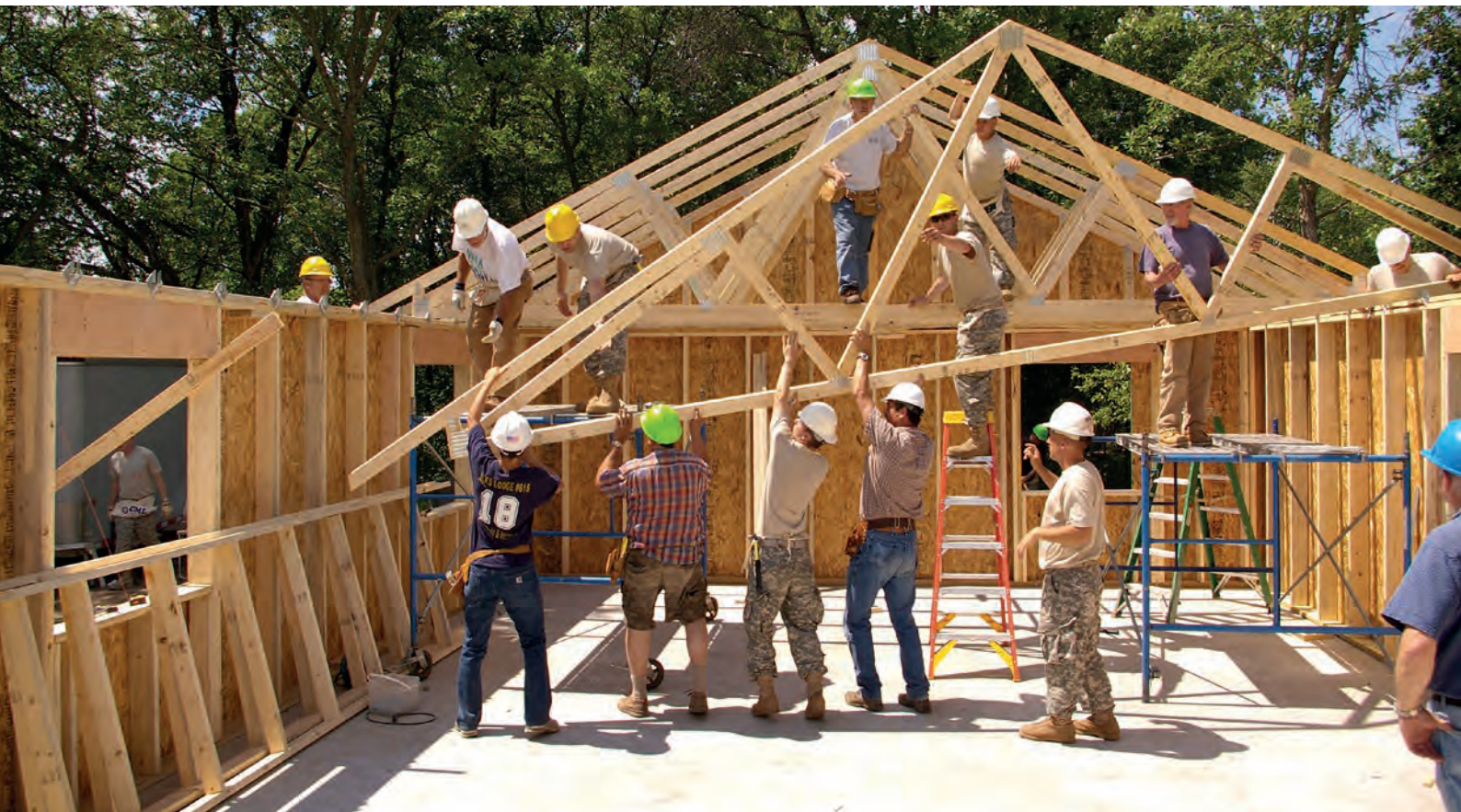
Ryc. 3. „Szybkościowy” montaż szkieletowego domu półprefabrykowanego w ramach akcji Habitat for Humanity; Źródło: Wikimedia Commons ( https://commons.wikimedia.org/wiki/File:Defense.gov_photo_essay_100713-A-51700-167.jpg ), fot. Nicholas Olson, 2010, domena publiczna)
