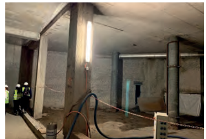
Fot. 9. Miejsce połączenia Kompleksu Varso z pasażami Dworca Centralnego, widoczna różnica w technologii wykonywania elementów żelbetowych w latach 70. XX w i obecnie
