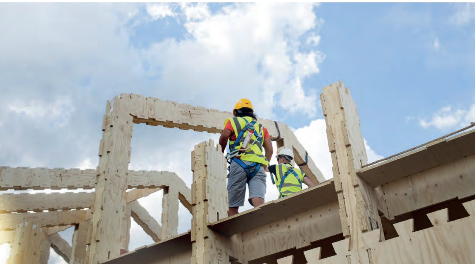
Ryc. 5. Budowa domu z gotowych modułów z drewna klejonego w Warwickshare w Wielkiej Brytanii, według konceptu WikiHouse; Źródło: www.wikihouse.cc na licencji Creative Commons (Open Systems Lab: The DiMA Housing Manual ver. 1.1, 05.2018: s.17)
