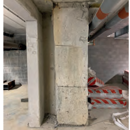
Fot. 7. Widoczne przecięcie ściany szczelinowej wybudowanej pomiędzy dwoma działkami budowlanymi
