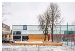
Fot. arch. sM4 Pracownia Architektury Brataniec
