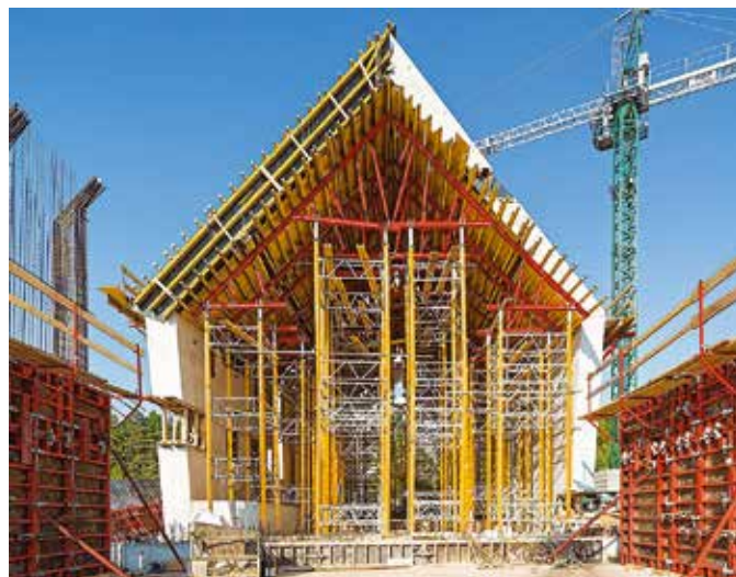
Rusztowanie podporowe MULTIPROP - podparcie deskowania stropowego
