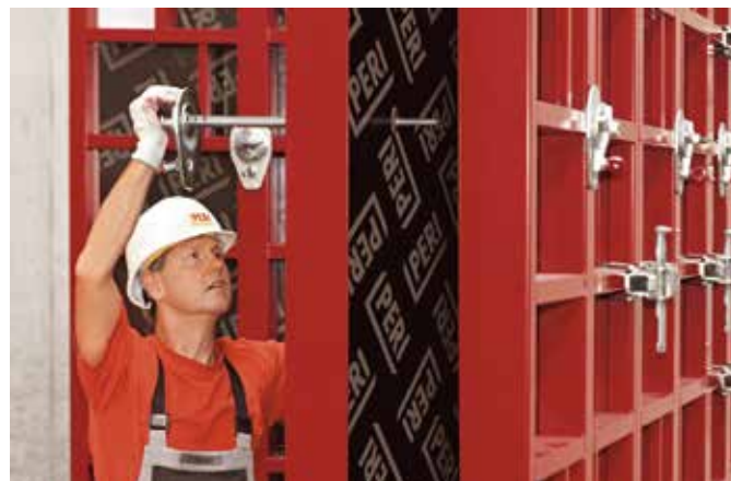
Deskowanie MAXIMO - jednostronna obsługa ściągów
