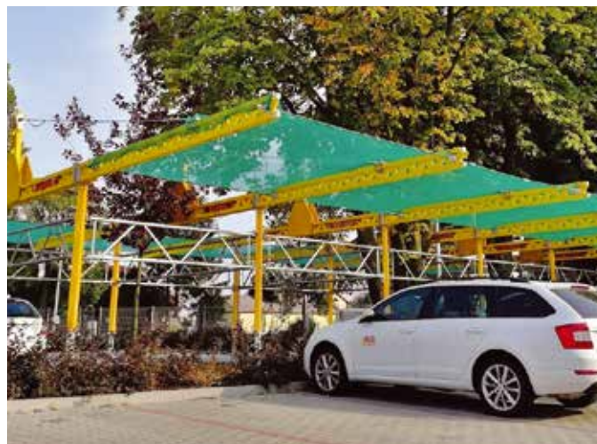
Rusztowanie podporowe MULTIPROP - rozwiązanie specjalne
