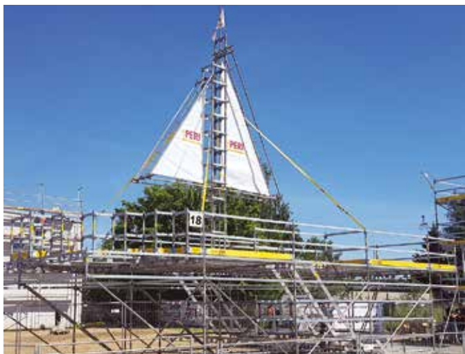
Rusztowanie PERI UP Flex - zastosowanie specjalne
