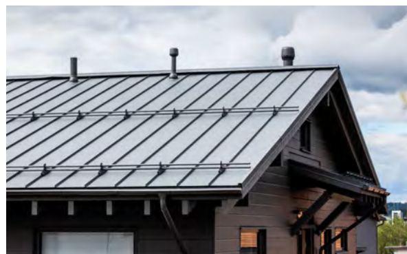
Fot. arch. SSAB
