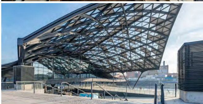
Rys. 10 a i b. W obszarze budownictwa infrastrukturalnego dobry przykład to ostatnio oddany do eksploatacji podziemny Dworzec Łódź Fabryczna. Wybudowano go w wykopie o głębokości 18 m, a perony kolejowe znajdują się na najniższym poziomie dworca
