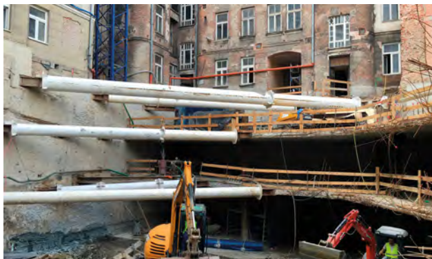
Rys. 4. Widok na sąsiednie budynki oraz wykop z systemem rozparcia fragmentami stropów i rozporami [fot. K. Traczyński]
