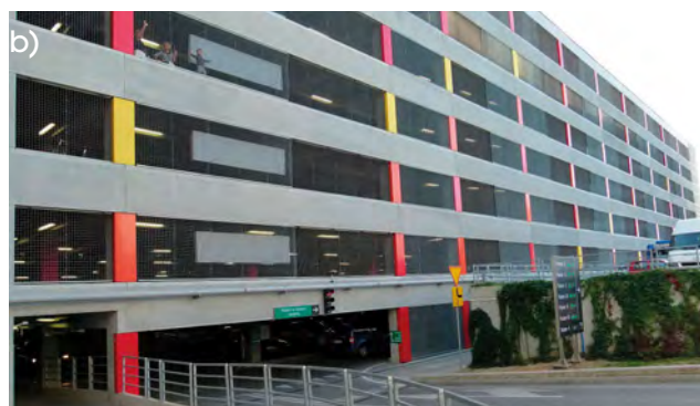
Fot. 8. Oparcie belek na słupach na podporach typu BSF (a) oraz konstrukcja Parkingu ECHO – Kielce wykorzystująca ten rodzaj połączeń (b)
