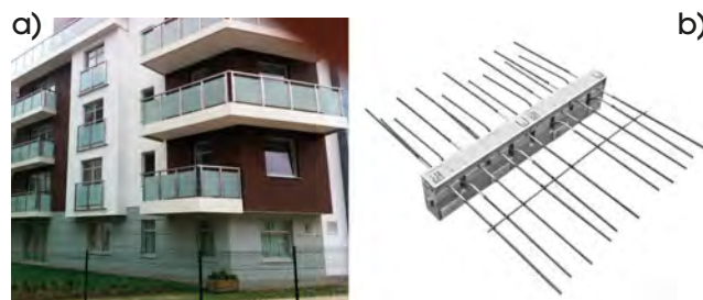
Fot. 9. Przykład zastosowania (a) elementów izolacyjnych ISOPRO (b) w zespole budynków mieszkalnych przy ulicy Czarny Dwór w Gdańsku
