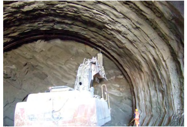
Rys. 9. Montaż łuków stalowych IPE 180 (opracowanie własne)
