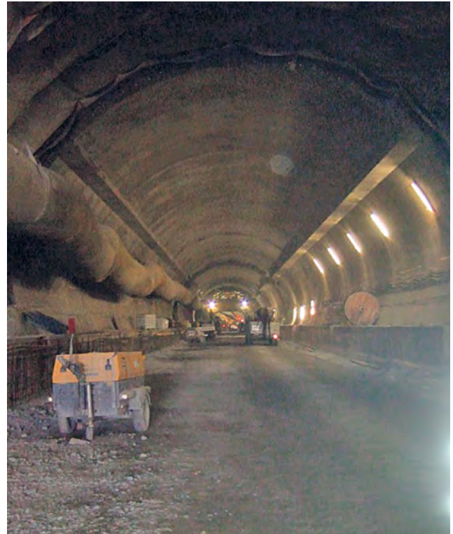
Rys. 12. Stan wydrążenia tunelu na dzień 26.01.2018 (opracowanie własne)
