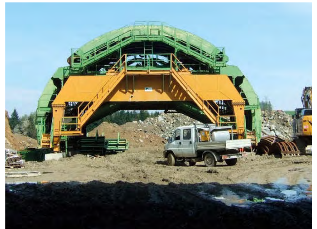
Rys. 10. Deskowanie obudowy ostatecznej (opracowanie własne)
