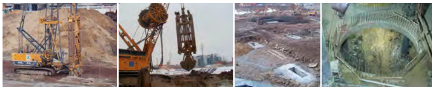
Rys. 2. Budowa części podziemnej obiektu metodą stropową: a) hydrofrez, b) chwytak, c) murki prowadzące dla baret, d) otwór technologiczny w stropie pośrednim [9]
