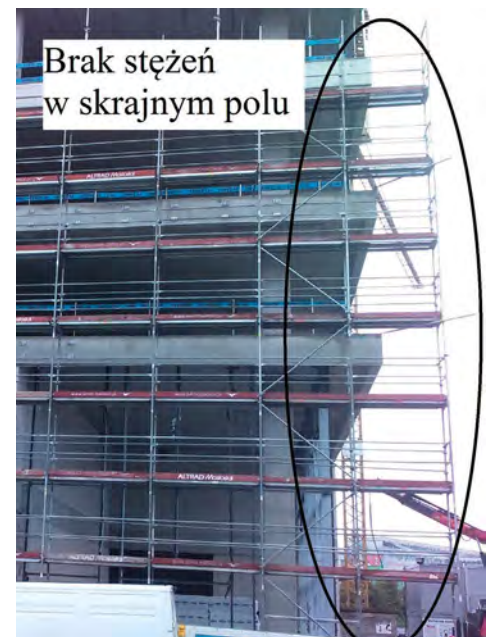
Rys. 2. Rusztowanie fasadowe (W07 w badaniach) bez stężeń w skrajnym niekotwionym polu
