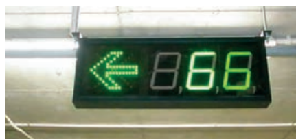
Rys. 4. Informacja wizualna w garażu sygnalizująca usytuowanie i liczbę wolnych stanowisk postojowych
