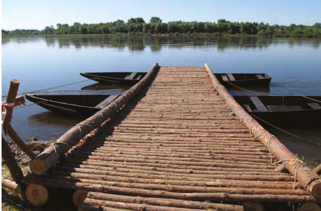
Rys. 7. Replika Mostu Jagiełły, odbojnice na krawędziach pomostu, w oddali widoczny brzeg Kępy Śladowskiej
