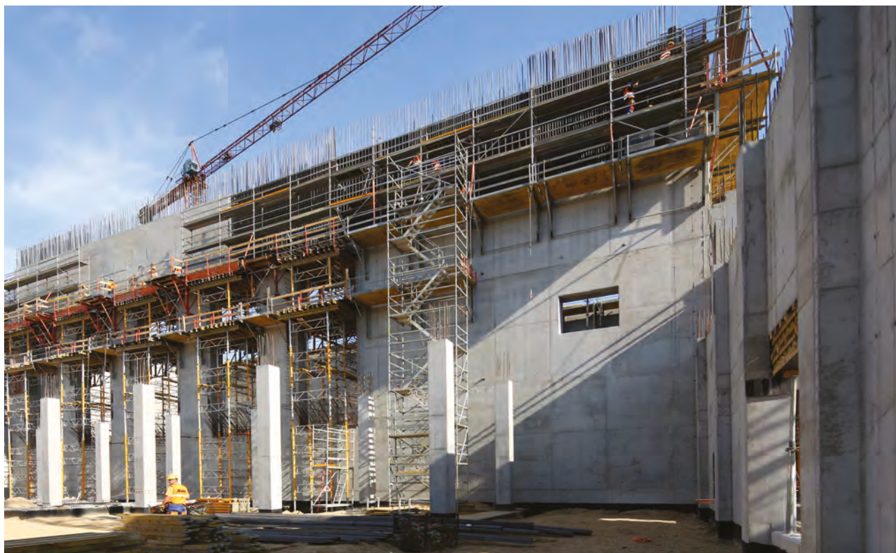
ZTPOK Bydgoszcz – widok na realizowane ściany bunkra i słupy hali garażowej
