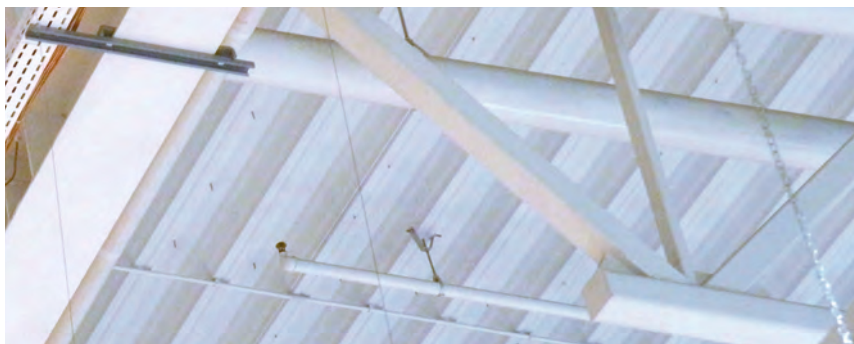
Fot. 3. Dźwigar (płatew kratowa) bez elementu mocowania cięgna stężającego (kadr z fot. 1.)
