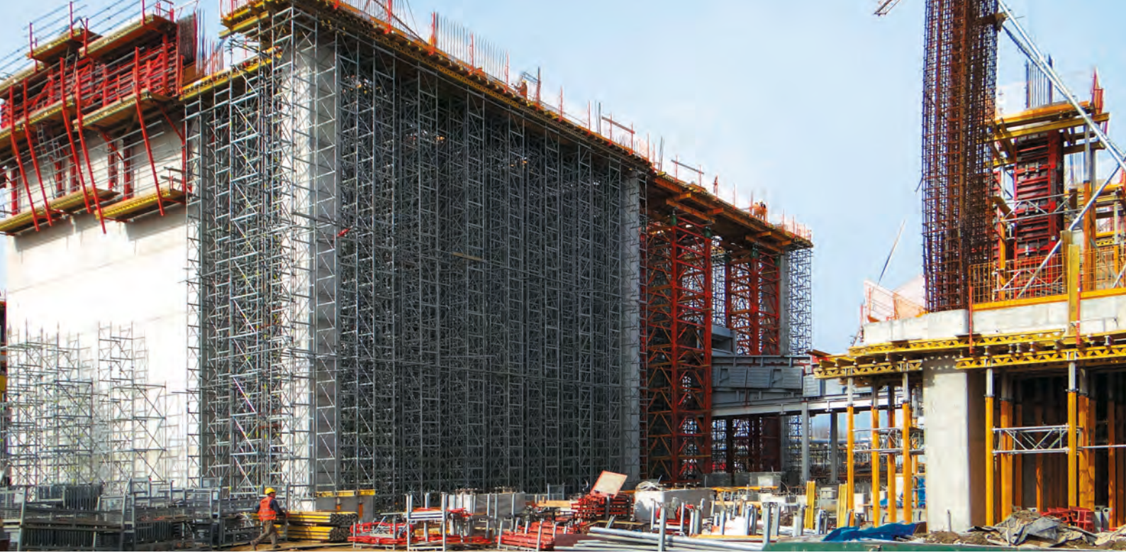
ITPOE Rzeszów – po prawej podparcie stropu +21/+24 bunkra, po lewej realizowana hala instalacji
