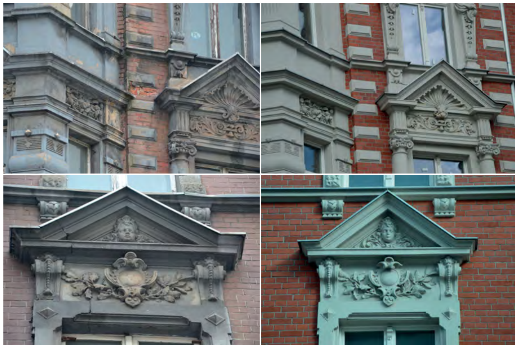
Rys. 2., 3. Widok ozdobnych naczółków okiennych przed renowacją budynku, rok 2014 (5) i po renowacji budynku, rok 2017 (5)
