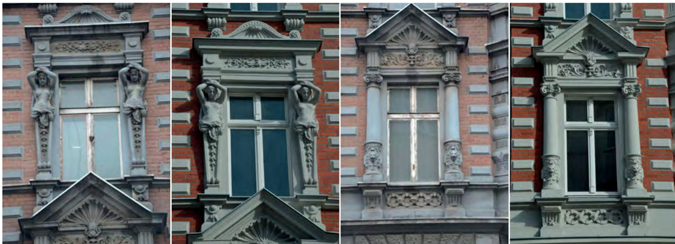
Rys. 4., 5. Widok sztukaterii pionów ozdobnych przed renowacją budynku, rok 2014 (5) i po renowacji budynku, rok 2017 (5)
