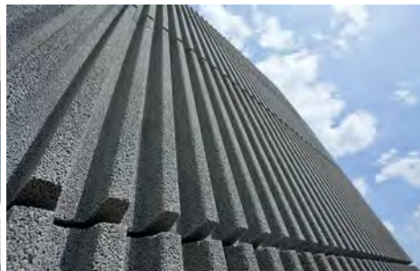
Ekranu akustyczne przy drodze S8
