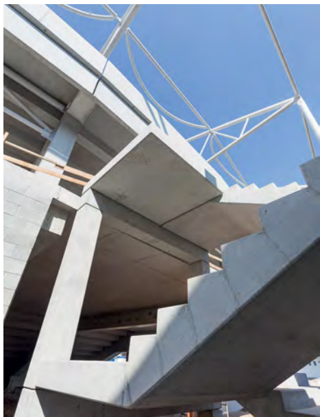
Płyty audytoryjne, stopnie komunikacyjne, stropy filigran, słupy i belki, Wrocław Stadion Olimpijski
