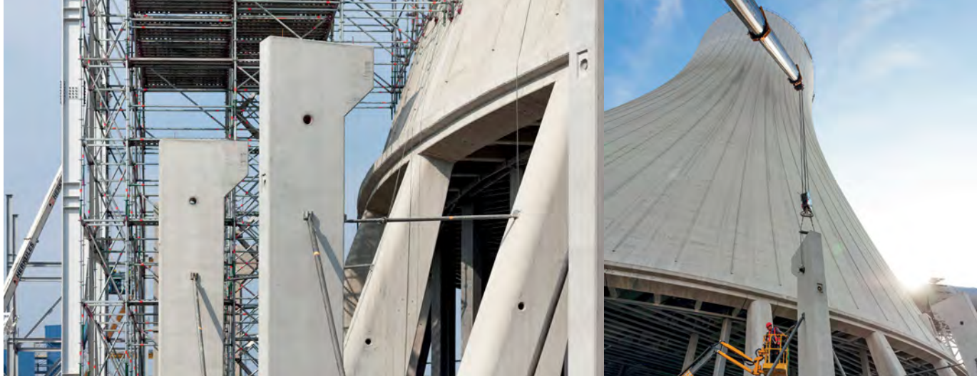
Prefabrykowane słupy, belki i ściany w budowie elektrowni Opolo
