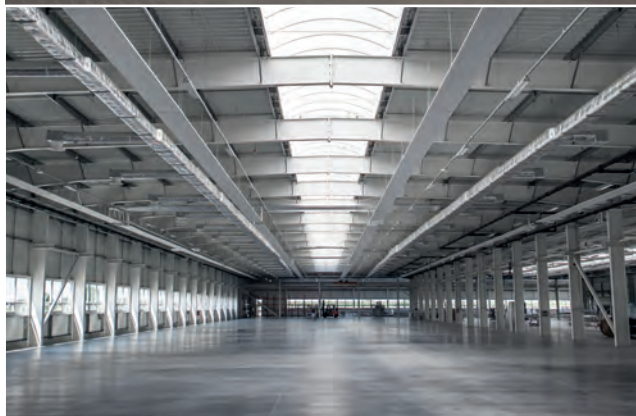
Obiekt wielkopowierzchniowy zrealizowany dla firmy Schweiker. Specjaliści z firmy Jakon zastosowali tutaj system grzewczy oparty na sufitowych promiennikach zasilanych wodą
