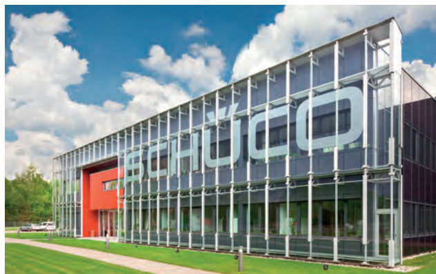
Budynek Schüco – zrealizowany przez firmę Jakon w 2009 roku. Obiekt został wyposażony w dwupowłokową elewację, która wspiera naturalną wentylację budynku
