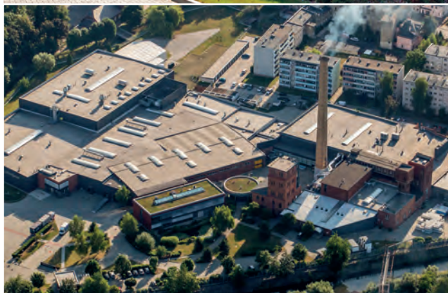
Nowatorski projekt zrealizowany w Głuchołazach dla firmy Schattdecor. Jednym z kluczowych aspektów w przypadku tej realizacji było zrozumienie i wdrożenie procesu odzysku ciepła
