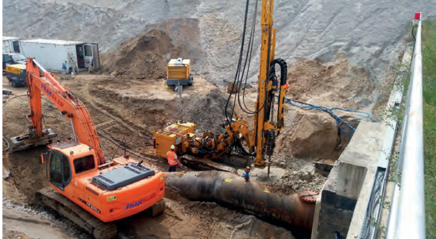
Rys. 4. Rurociąg przebiegający przez centralną część placu budowy [5]
