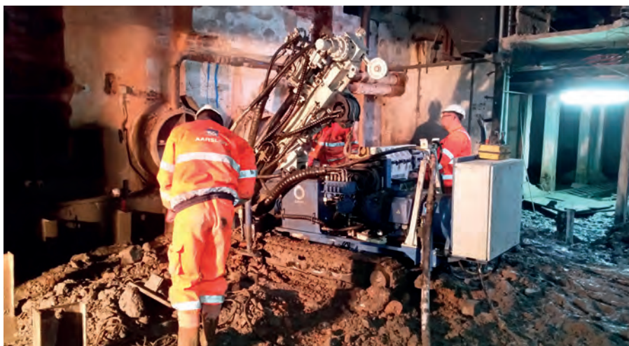
Rys. 7. Wykonywanie kolumn wiertnicą małogabarytową wewnątrz budynku [5]
