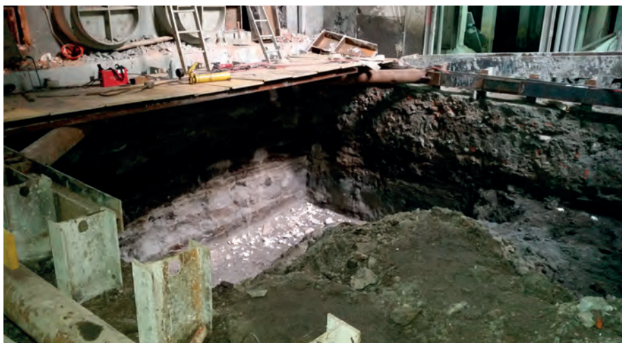
Rys. 6. Widok na obudowę wykopu [5]
