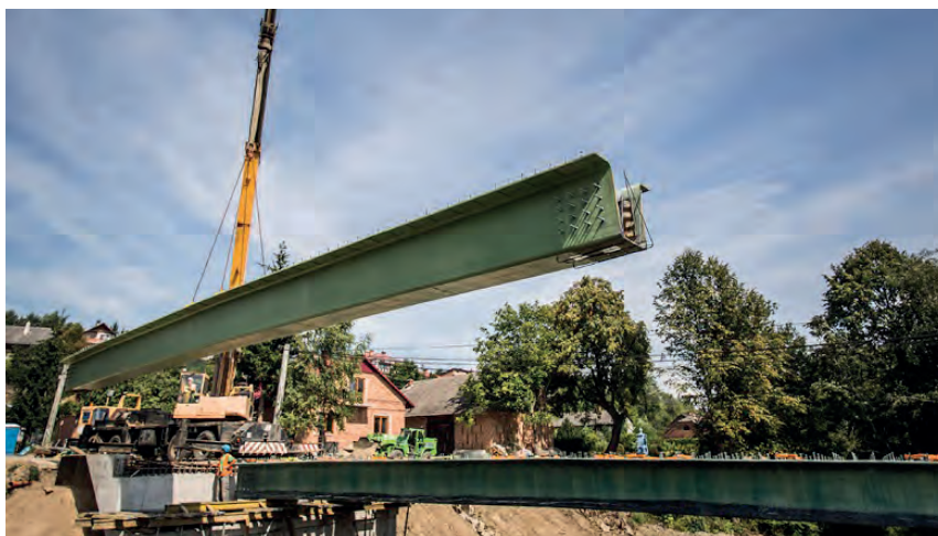
Rys. 8. Montaż dźwigarów kompozytowych na podpory
