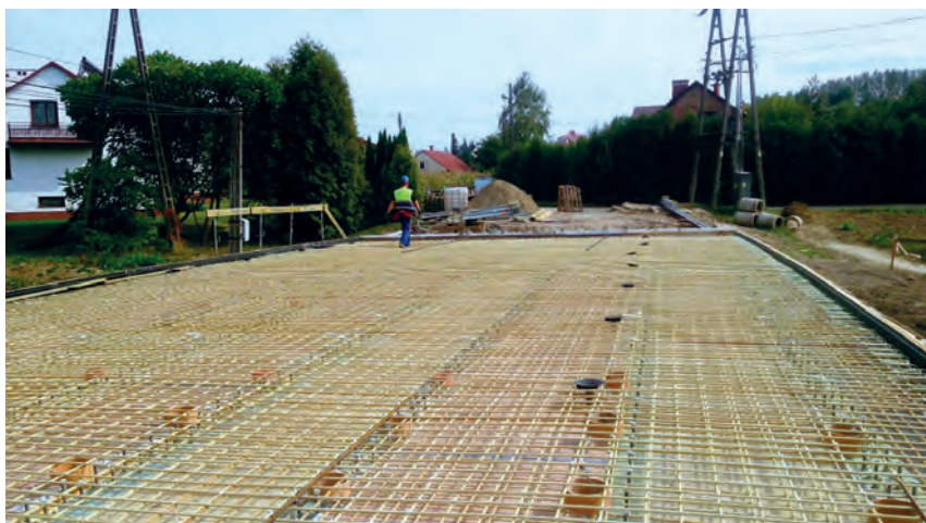
Rys. 9. Zbrojenie kompozytowe płyty pomostu przed betonowaniem
