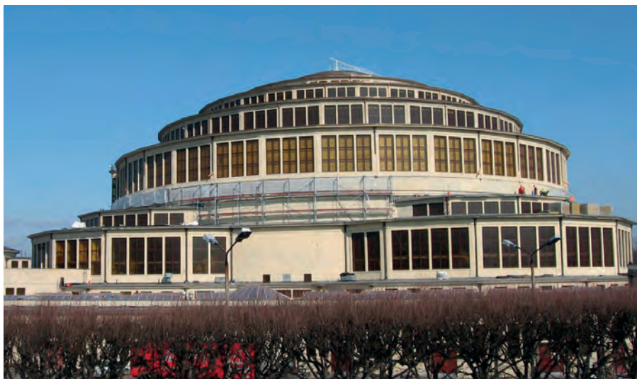
Rys. 6. Hala Stulecia we Wrocławiu – widok po renowacji Fig. 6. Centennial Hall in Wrocław – view after renovation
