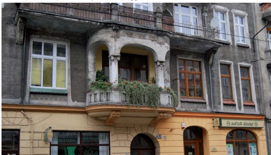
Fot. 2. Przykłady różnych konstrukcji balkonów/loggii zróżnicowanych materiałowo.
