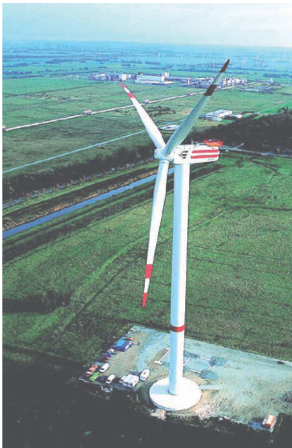
Fot. 1. Siłownia Brunsbüttel
