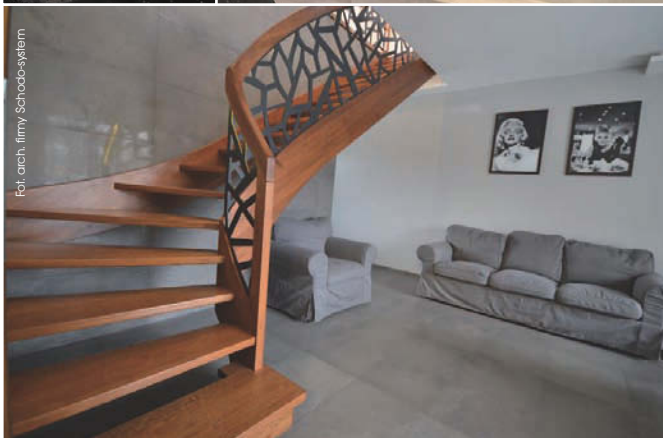
Rys. 8, 9. Wypełnienie balustrady wycinane laserowo
