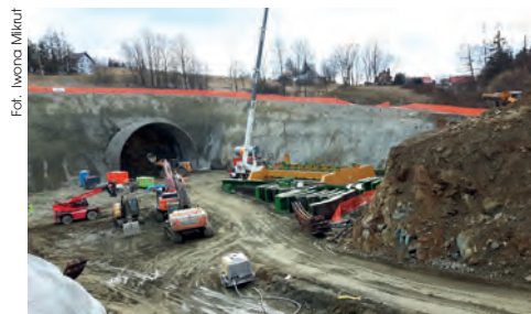
S7 Przeszkoda – Skomielna Biała. Budowa tunelu
