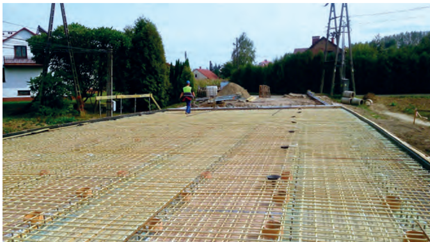
Rys. 9. Zbrojenie kompozytowe płyty pomostu przed betonowaniem
