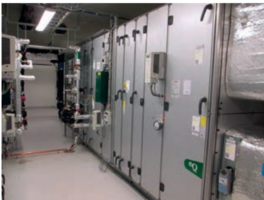
Rys. 2. Nowoczesna centrala sekcyjna w wydajności kilkudziesięciu tysięcy metrów sześciennych na godzinę, wyposażona w rozbudowany system uzdatniania powietrza, regulacji i nadzoru
