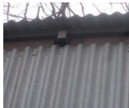
Rys. 6. Stalowa blacha ocynkowana na ścianach i dachu obiektu magazynowego
