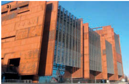
Rys. 9. Przykład zastosowania okładziny ze stali typu Cor-Ten, o podwyższonej odporności na warunki atmosferyczne, na budynku ECS w Gdańsku: a) fragment elewacji budynku, b) składowana blacha elewacyjna z widocznymi zawieszami
