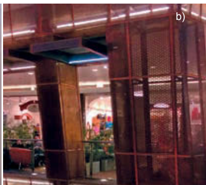
Rys. 11. Przykłady lekkich przegród budowlanych z materiałów metalowych
