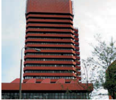
Rys. 7. Budynek użyteczności publicznej w Poznaniu
