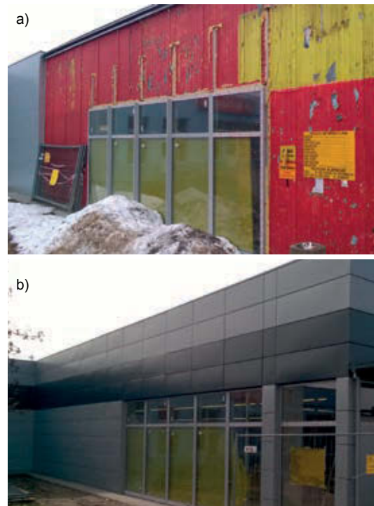
Rys. 1. Przykład szybkiej modernizacji i renowacji obiektu a) obiekt w trakcie robót renowacyjnych, b) trzy tygodnie później
