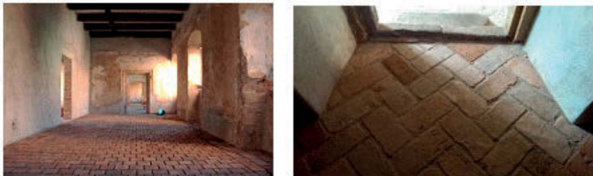
Rys. 2. Odzysk materiałów ceramicznych i kamiennych prowadzony w trakcie remontu zespołu pałacowego w Gorzanowie. Po lewej posadzka wykonana z dachówek ceramicznych. Po prawej posadzka z kamienia pochodzącego z rozbiórki innego obiektu [10]
