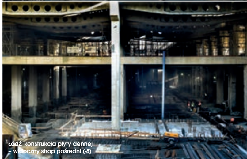
Łódź: budowa płyty stropowej na gruncie – poziom -8
