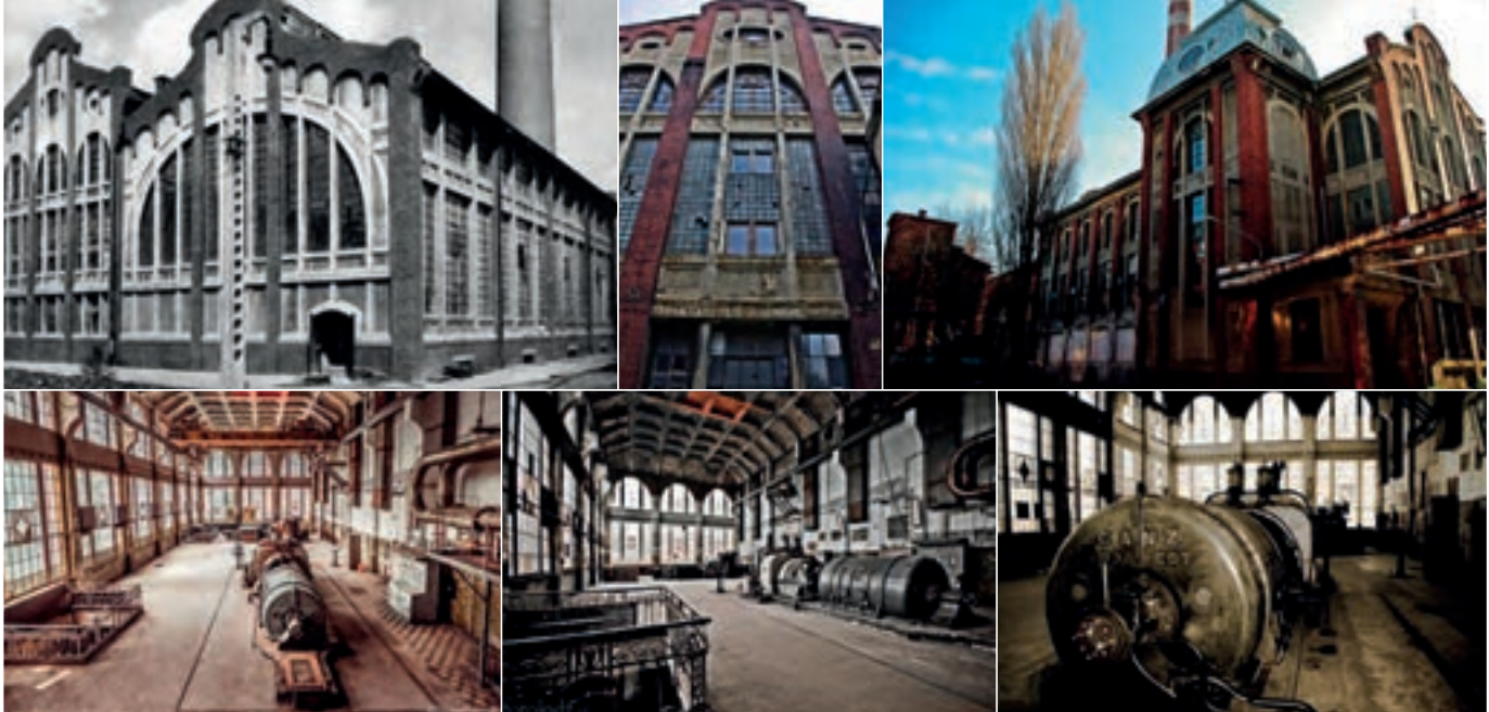
Fot. 8. Elektrownia w kompleksie Scheiblera (Łódź)
