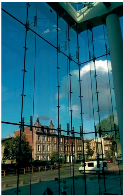
Fot. 3. Szklana fasada budynku ze szklanymi elementami nośnymi
