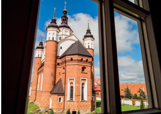
W ramach RPOWP 2007–2013 przeprowadzono rewitalizację części zabytkowych pomieszczeń klasztornych Pałacu Archimandrytów w Supraślu
