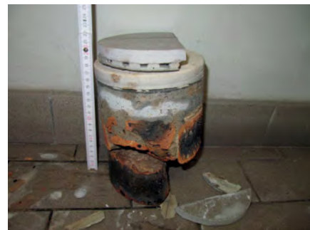
Rys. 3. Odkrywka podłogi na gruncie w budynku użyteczności publicznej; warstwy od góry: posadzka z płytek ceramicznych na kleju, wylewka samopoziomująca, podkład betonowy, stara posadzka ceglana na podbudowie gruntowej
