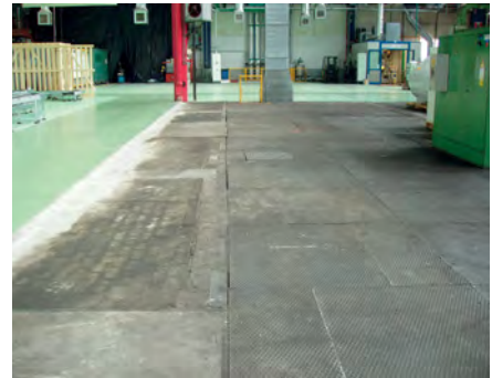
Rys. 6. Nowa posadzka żywiczna na starej posadzce z płytek betonowych
