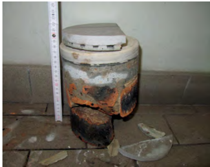
Rys. 4. Odkrywanie posadzki w hali; widoczne kolejne warstwy
