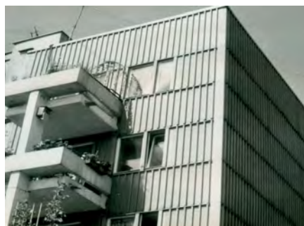
Fot. 5. Budynek ze ścianą „BISTYP 4”
