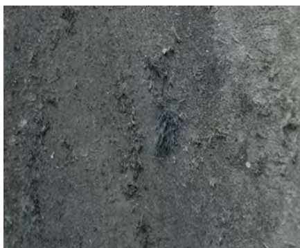
Fot 1 i 2. Azbesto-cement. Z lewej: Powierzchnia płyty falistej azbestowo-cementowej pokrycia dachowego, w dole fali widoczne słabo związane z matrycą cementową niebieskie włókna azbestu krokidolifowego, które odsłoniły się po wyptukaniu spoiwa cementowego. Po prawej: Gąbczasta struktura płyty azbestowo-cementowej pokrycia dachowego, powstała wskutek wieloletniej eksploatacji i działania deszczów. Widoczne w przelamie białe włókna to chryzotyl. Wskutek rozpuszczenia spoiwa nastąpił na powierzchni wzrost zawartości azbestu w produkcie z ok 12% do ok 20%.
