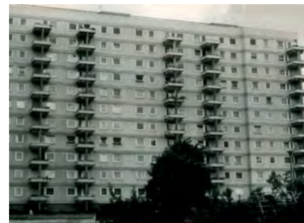
Fot. 4. Budynek ze ścianą „BISTYP 3”
