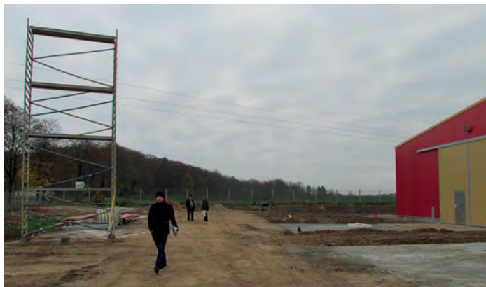
Widok sytuacyjny miejsca wypadku – widoczne po lewej rusztowanie przejezdne, po prawej budowana hala magazynowa, przebiegająca nad placem budowy linia średniego napięcia
