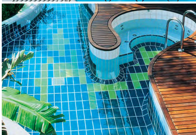
Fot. 1-3. Wielkość basenu to rzecz bardzo indywidualna. Istotne jest, aby kształt basenu był dostosowany do funkcji, jakie ma on spełniać
