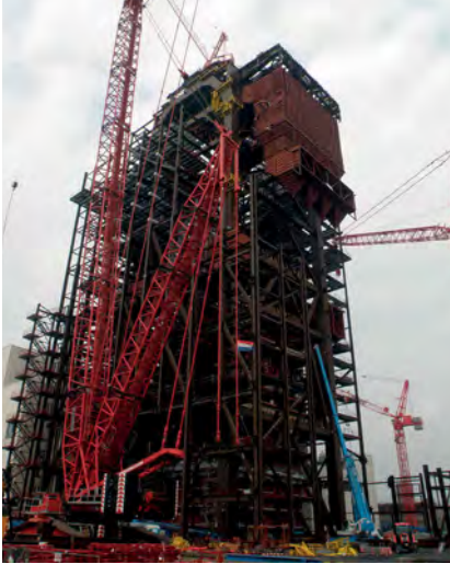
Rys. 1. Konstrukcja budynku kotła głównego
