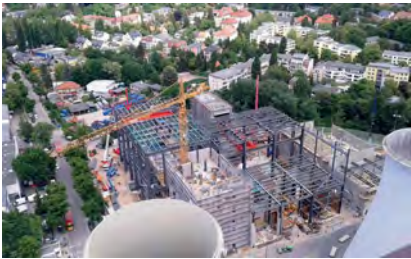
Rys. 3. Widok z góry przed montażem budynku kotła elektrociepłowni w Lichterfelde (widoczny szkielet główny budynków turbin UMA i UMB)
