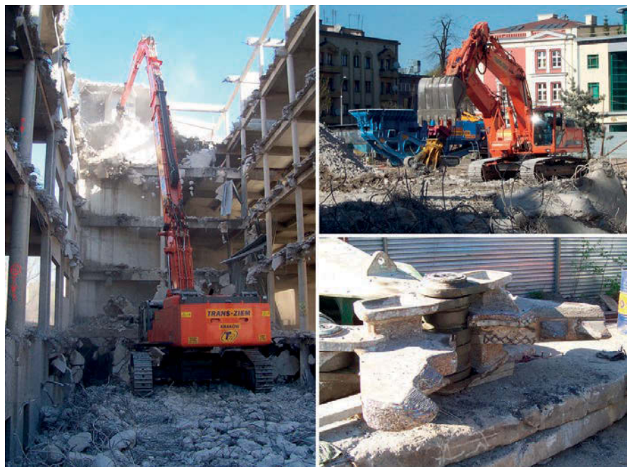
Rys. 3. Mechaniczna rozbiórka żelbetonowej konstrukcji nośnej parkingu piętrowego w centrum Opola, z użyciem gąsienicowych koparek wyburzeniowych wyposażonych w hydrauliczne nożyce na teleskopowym ramieniu
