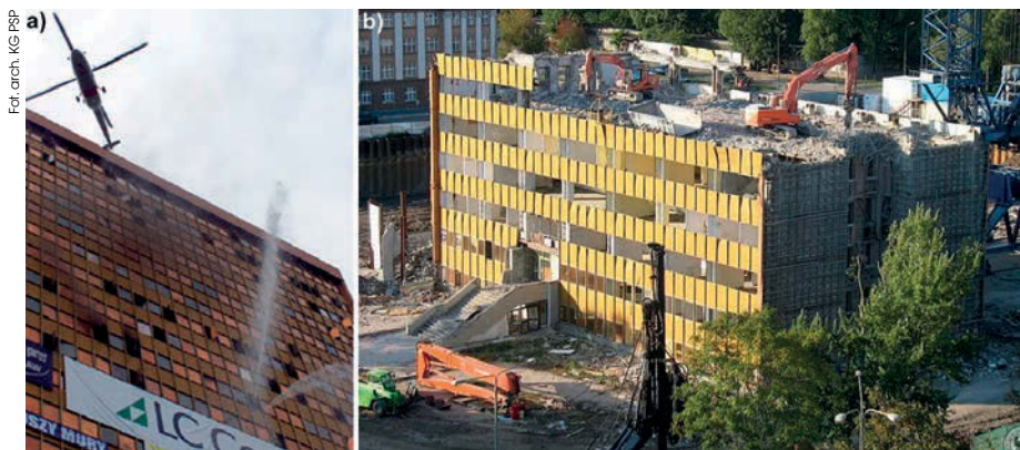
Rys. 2. Mechaniczna rozbiórka wieżowca POLTEGOR we Wrocławiu, a) ćwiczenia strażackie „POLTEGOR 2007” poprzedzające rozbiórkę [9], b) obciążenia wykonawcze Q_{cd} wywołane przez ruchome ciężkie maszyny oraz Q_{ce} wywołane przez skupienie zużytych materiałów [10]
