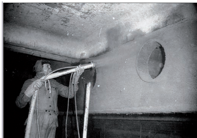
Rys. 11. Nakładanie natrysku na konstrukcję stalową
