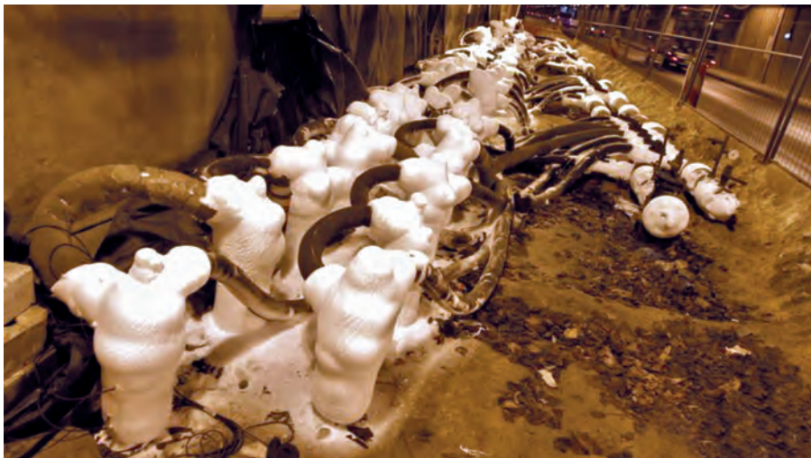
Rys. 2. Instalacja rozdzielająca LIN do rur mrozeniowych [3] Installation dividing LIN to pipe freezing.
